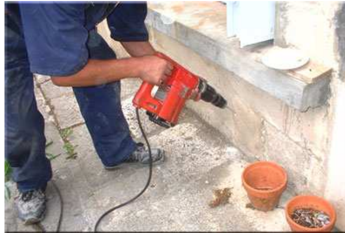
Perçage des puits d'injection
