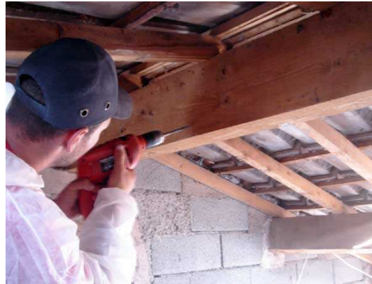
Perçage des puits d'injection
